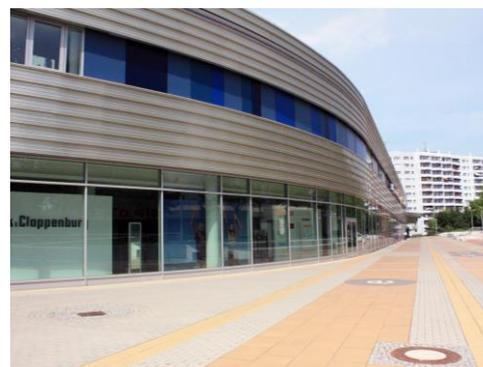
Pfosten-Riegel-Fassade mit gebogenen Aluminiumprofilblechen (Kalzip)
