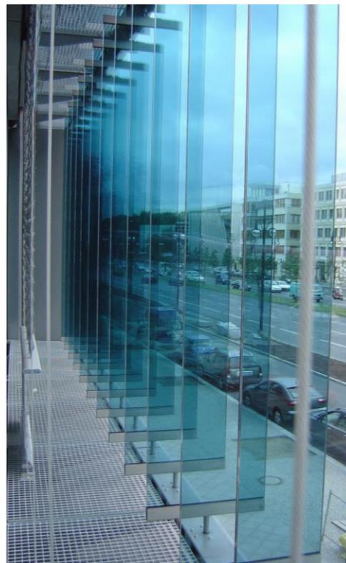
Fassadenzwischenraum mit vertikale Glaslamellen und außenliegendem Sonnenschutz
