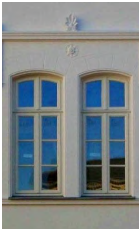
Detailansicht nach der Rekonstruktion
