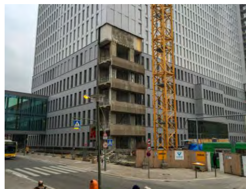
Ansicht Bestandsfassade und sanierte Fassade
