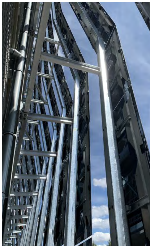
PV-Module auf Stahlunterkonstruktion
