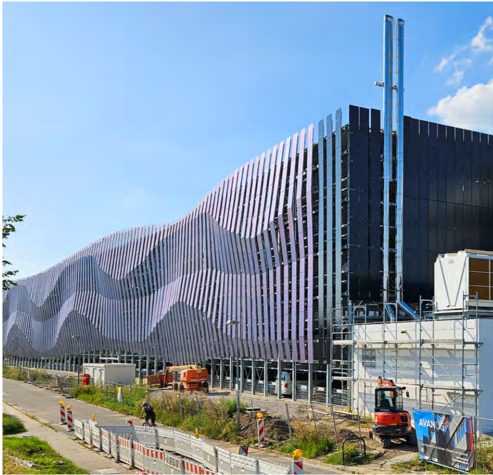
DHL-Campus, Parkhausfassade während der Bauphase, August 2023
