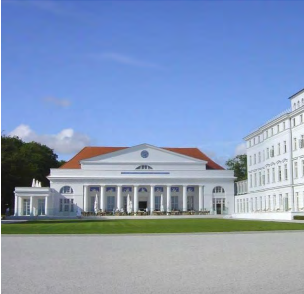
Vorderansicht Kurhaus von 1830 nach der Sanierung
