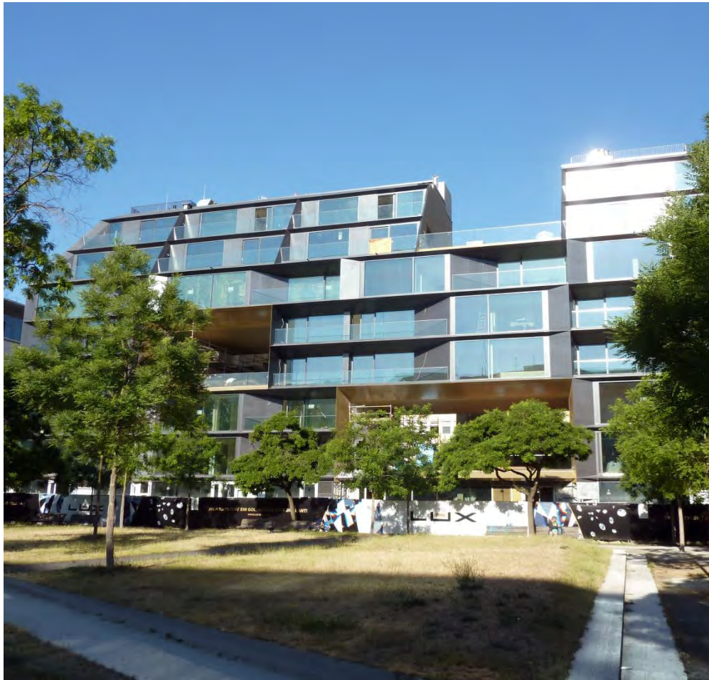
LUX Mittelstraße in Berlin, Ansicht während der Bauphase
