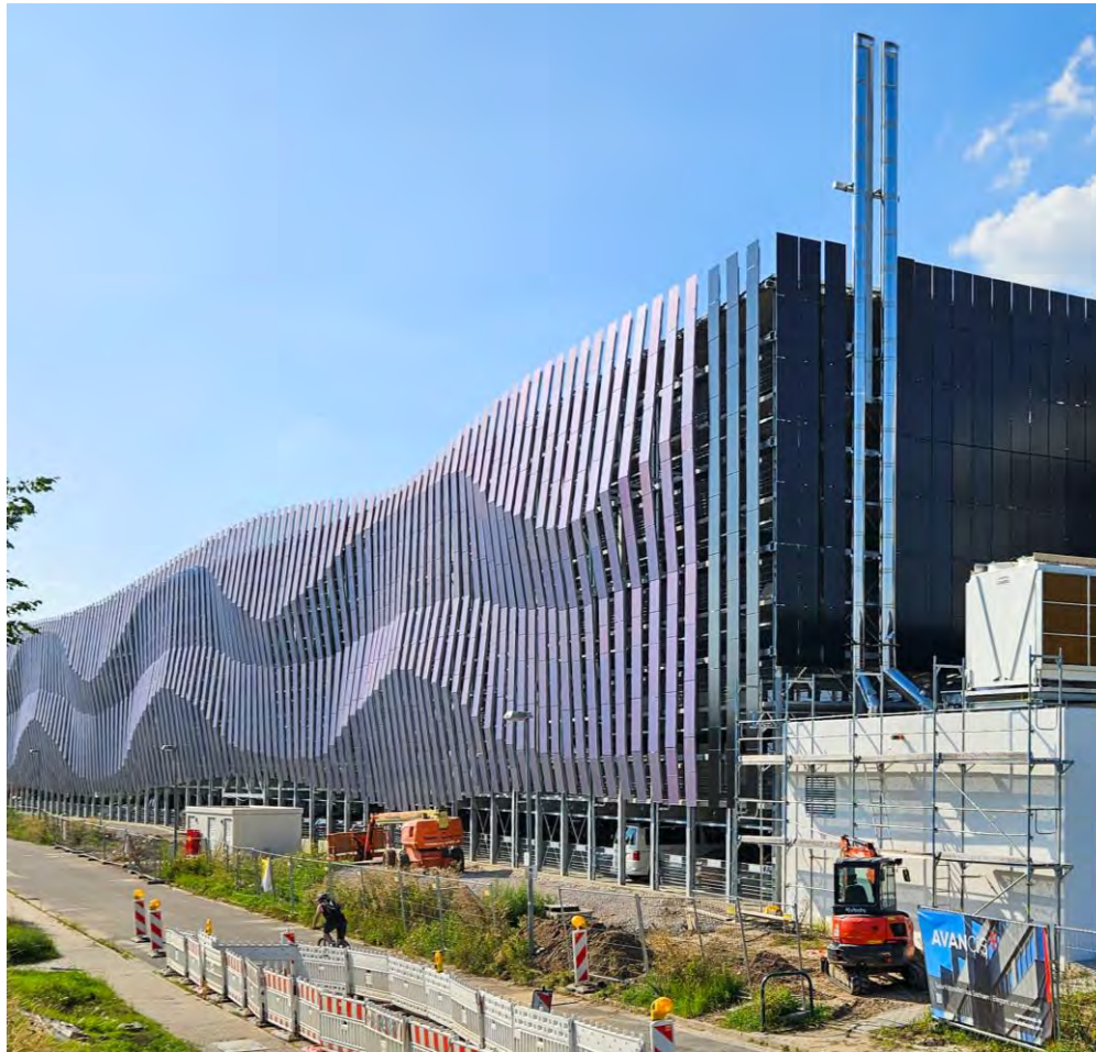
DHL-Campus, Parkhausfassade während der Bauphase, August 2023
