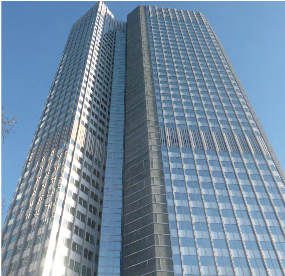
Fassadenansicht vor Sanierung
