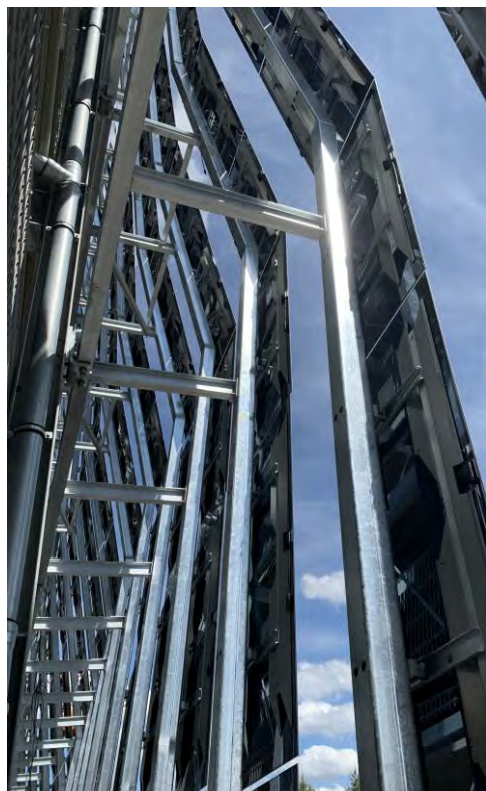
PV-Module auf Stahlunterkonstruktion
