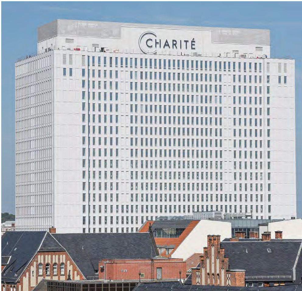
Charite nach Fertigstellung
