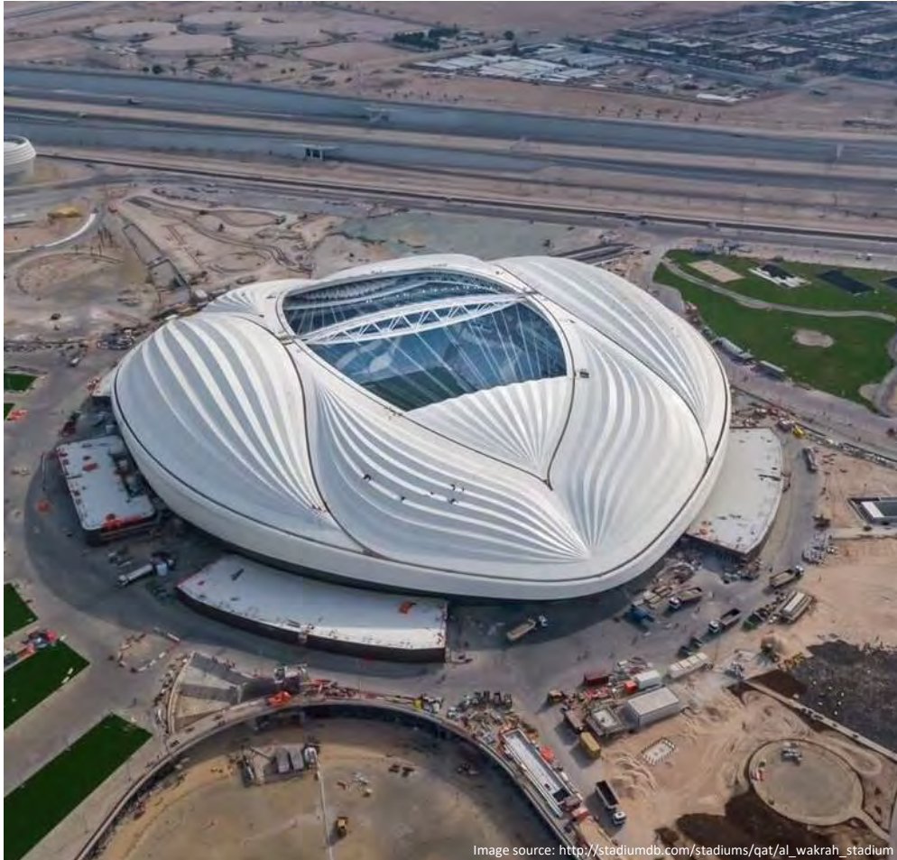
Al Janoub Stadium im April 2019
